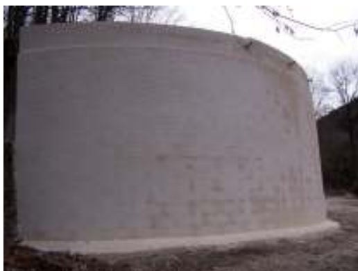
Réservoir de stockage (réhabilité en 2005)
